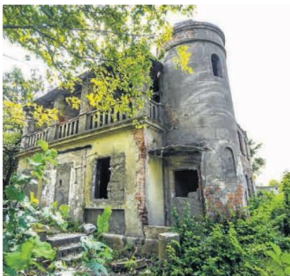
Obecny właściciel nieruchomości ma stare niemieckie plany willi oraz jej budynków gospodarczych. Może ktoś ją odbuduje?
